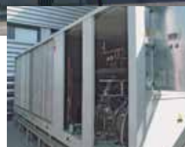
Grupo Farmacéutico Hefame, Getafe (Madrid) Enfriadora aire-agua compresor tornillo. Potencia instalada 960 kW. Climatización industria farmacéutica.
